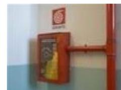
Le reti di idranti sono installate allo scopo di fornire acqua in quantità adeguata per combattere, tramite gli idranti ed i naspi ad esse collegati, l'incendio di maggiore entità ragionevolmente prevedibile nell'area protetta.
